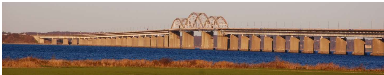
Den eksisterende Storstrømsbro
