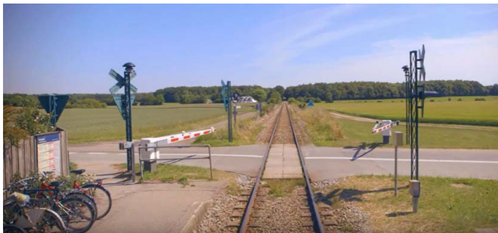
Figur 22 Eksisterende bomanlæg på Østbanen (Tokkerup) – typisk udformning med halvbomme
