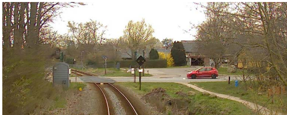
Figur 13 Eks. på krydsning med utilstrækkelig oversigt. Vemmetoftevej mod syd. BRT-chaufføren i retning mod Rødvig har dårlig oversigt mod vestre. Kilde: Video fra banestrækningen
