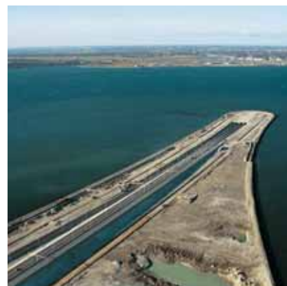
Rampeområde for sænketunnelen på Peberholm, Øresundsforbindelsen
