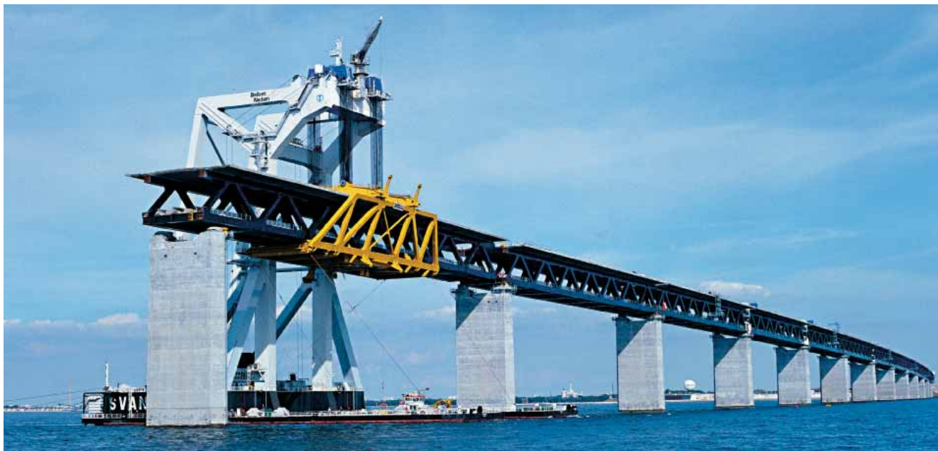
Montage af tilslutningsfag for overbygningen, Øresundsforbindelsen
