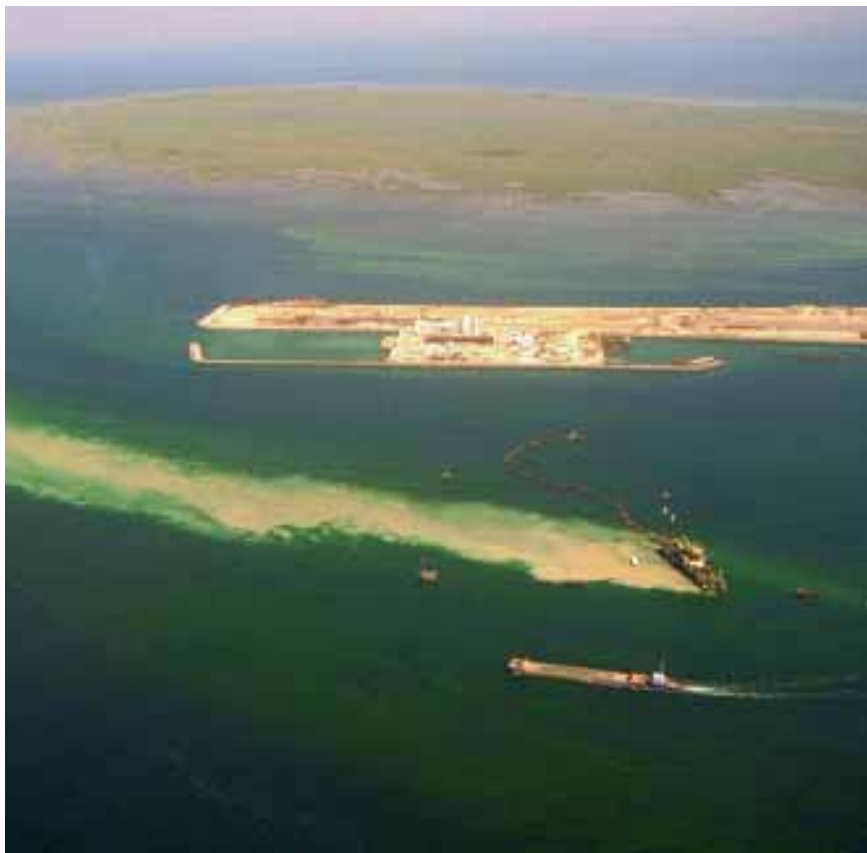
Gravemaskine af skære-sugetypen under byggeriet af Øresundsforbindelsen. Bemærk den store sedimentfane fra graveprocessen
