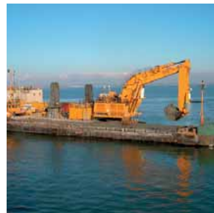
Eksempel på mekanisk gravemaskine (back hoe)
