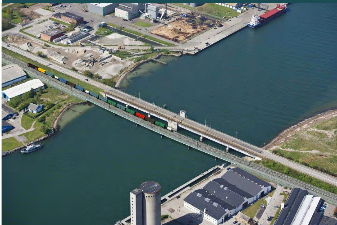
FIGUR 2.8 Masnedsundbroen fastlåses, og der bygges en ny dobbeltsporet jernbanebro
