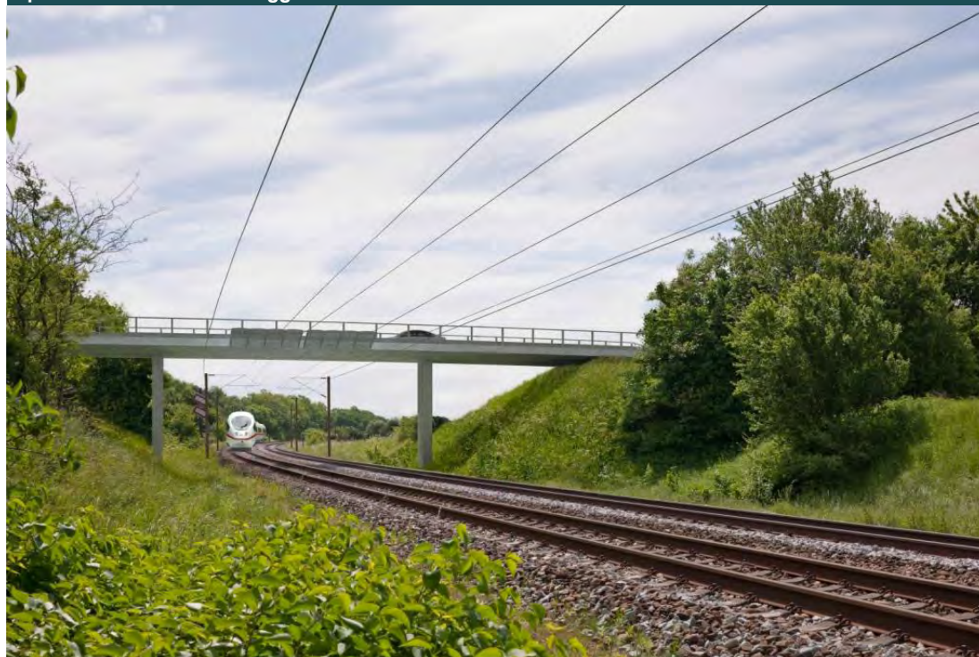
FIGUR 2.3 Der opsættes master for hver 30 – 100 m, og mere end 100 broer ombygges for at gøre plads til kørestrømsanlægget
